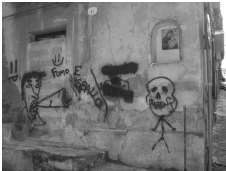
Il muro di una vecchia casa imbrattato dai vandali.
